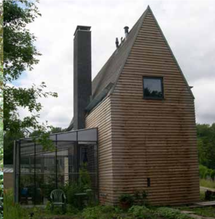
eigentijdse houtbouw op Fort Blauwkapel
