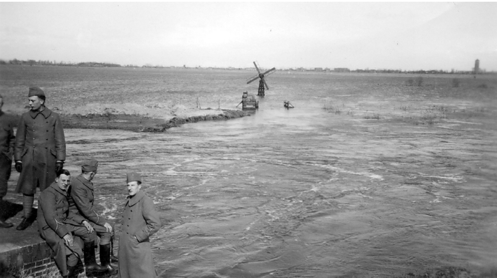
inundatie bij de Papsluis in het Land van Altena
